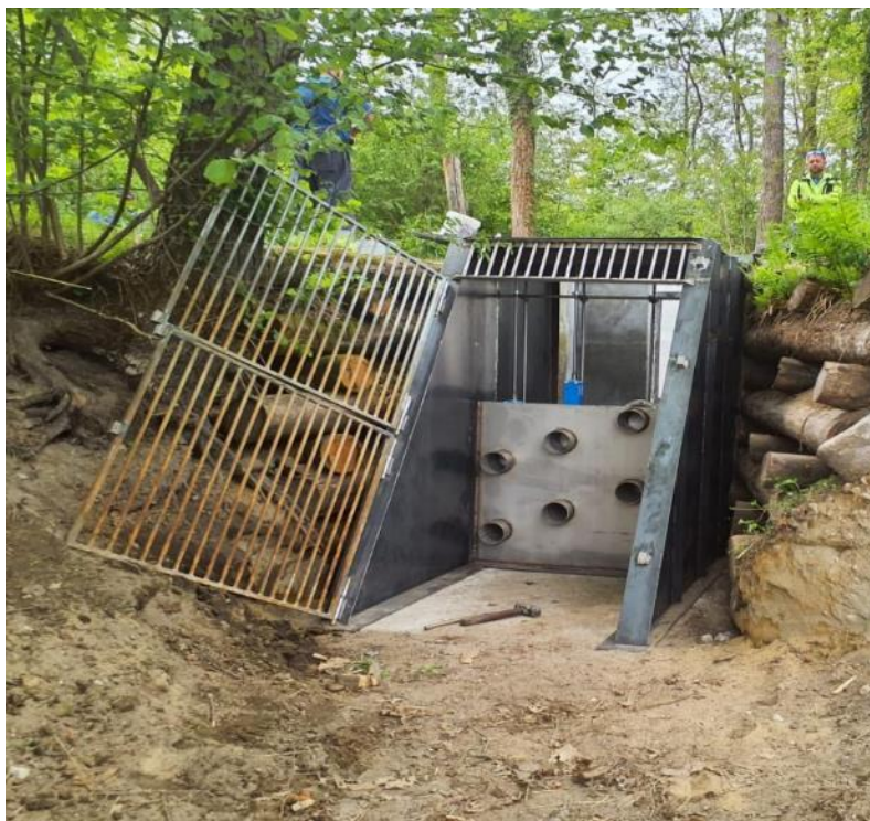
Figura 35: Immagine da monte della chiusa per la regolazione dei livelli idrici massimi e minimi, realizzata nell'ambito del progetto SPA e successivamente potenziata nell'ambito del progetto Life Insubricus presso lo stagno Peverascia (ARS01) nella ZSC IT2010011 "Paludi di Arsago".
