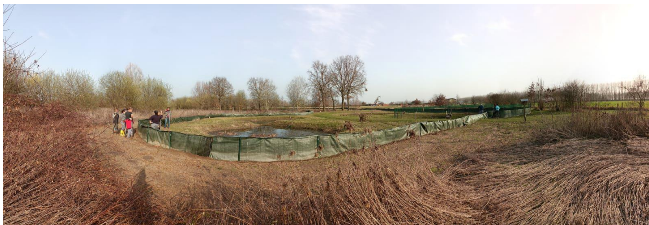
Figura 2 – La barriera nelle fasi finali di allestimento lungo il perimetro del sito di Cascina Lai nella ZSC IT1110035 Stagni di Poirino-Favari in provincia di Torino.
