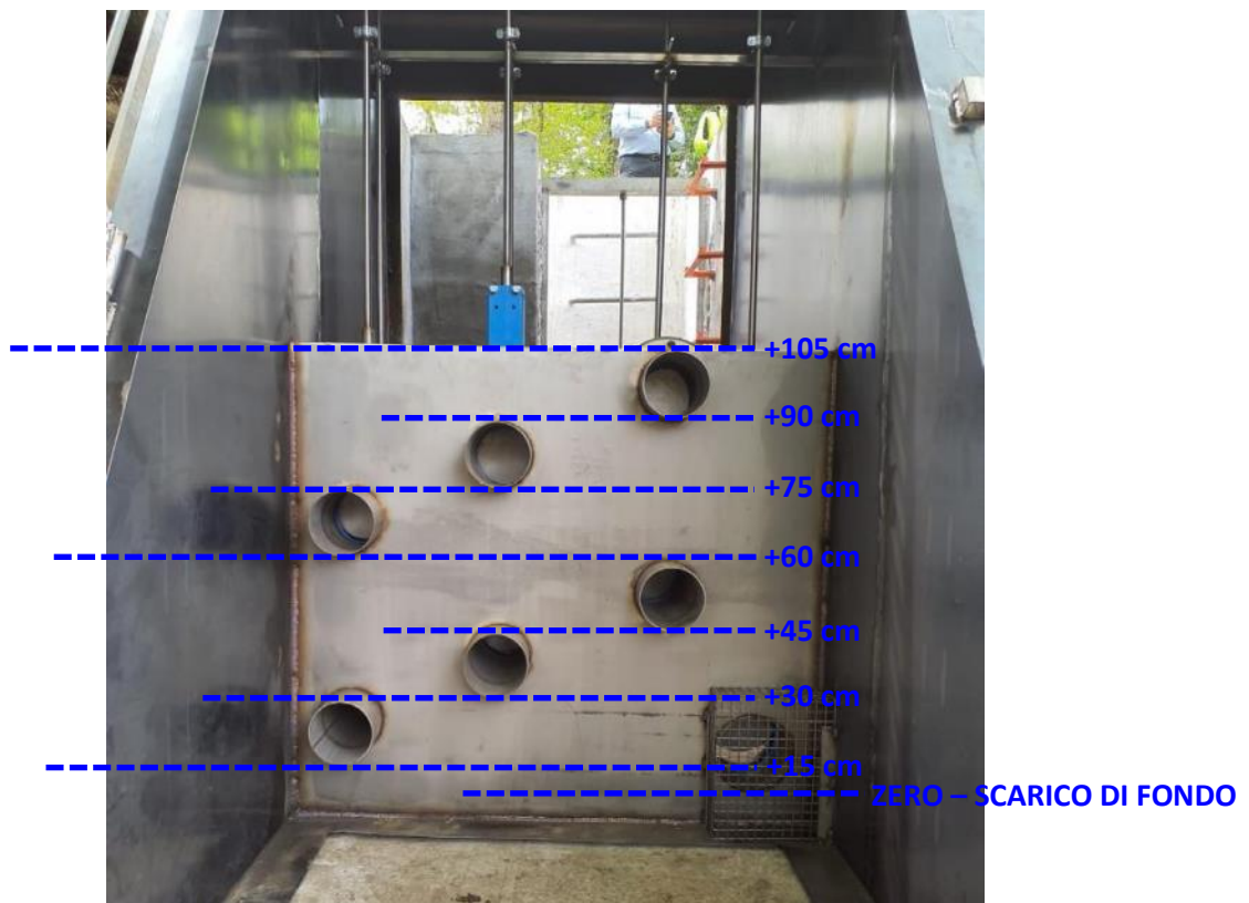
Figura 37: Vista da monte del sistema di valvole per la regolazione dei livelli minimi di riempimento dell'area umida ARS01 (intervalli discreti di 15 cm) e per il completo prosciugamento dell'area mediante scarico di fondo.
