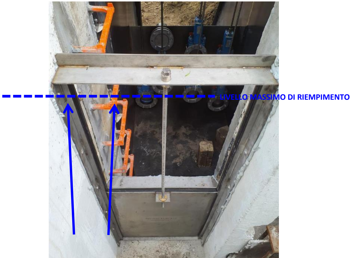
Figura 36: Vista da valle della paratoia a stramazzo per la regolazione dei livelli massimi di riempimento dell'area umida ARS01.
